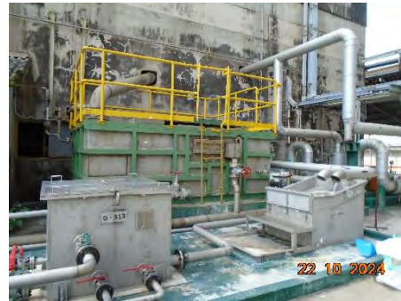
ภาพที่ 2-8 Powder Separator
