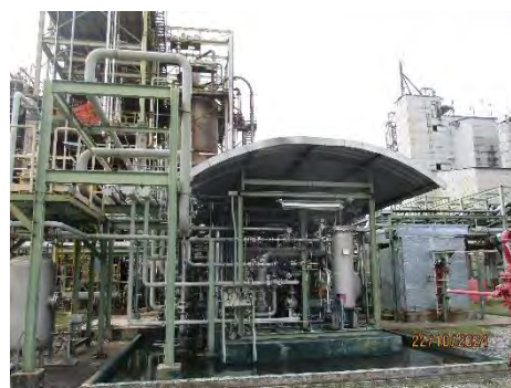
ภาพที่ 2-6 หน่วยงานกลับไอสารไฮโดรคาร์บอน (VOC Recovery Unit: VRU) ของโรงงานที่ 2 (ใช้ร่วมกับ PP2)
