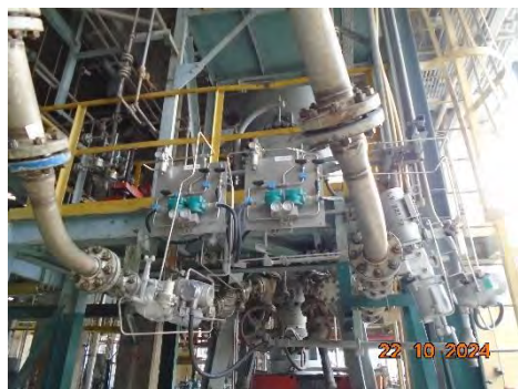
ภาพที่ 2-2 ระบบวาล์วควบคุมระหว่างถังปฏิกรณ์ และการตรวจสอบระบบวาล์วควบคุม และอุปกรณ์ควบคุม
