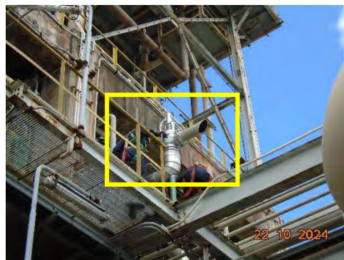
ภาพที่ 2-28 Safety Relief Valve
